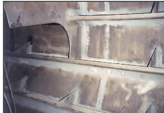
Cordones de soldadura alistados con chorro abrasivo previo a la aplicación del recubrimiento
