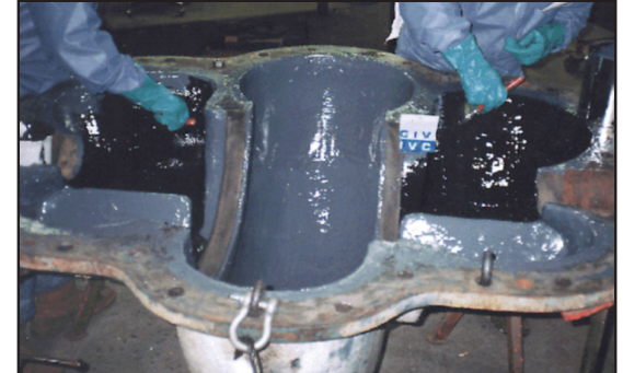
Aplicación de ARC 855.
