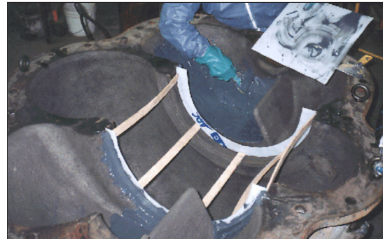
Reconstrucción con ARC 858.
