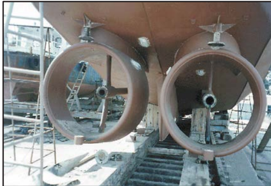
El rodamiento del eje no sella debido a la corrosión en la cara del reborde.
