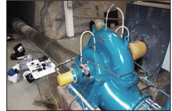
Bomba reinstalada y sometida a medición de eficiencia.
