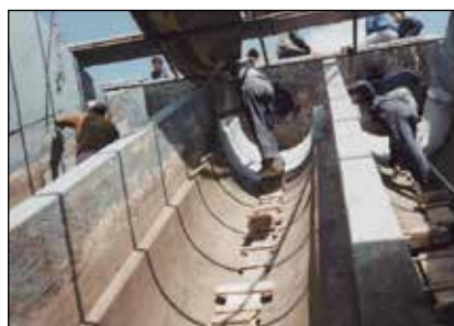
ARC 791 byl nanesen na správně připravené povrchy
