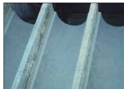
Koryta všech tří šnekových čerpadel byla ošetřena materiálem ARC 791
