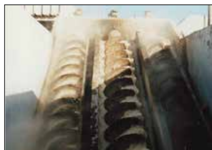
Před opravou byla v provozu tři šneková čerpadla.
