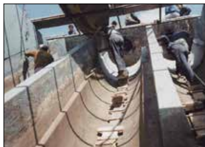
ARC 791 se aplicó a superficies correctamente preparadas
