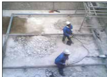
Preparación de la superficie
