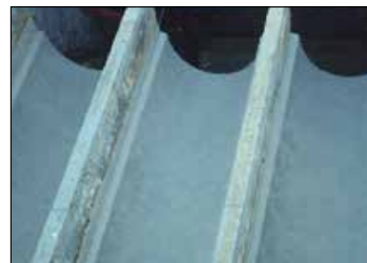
Las tres canaletas de las bombas están recubiertas con ARC 791
